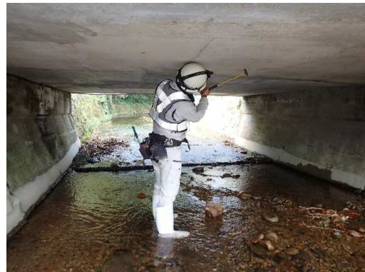
定期点検状況（地上）：氷川橋
