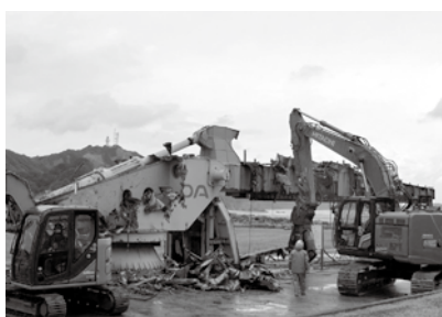
ロケットランチャの撤去作業の様子
