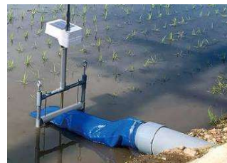
間断灌漑 自動給水栓
